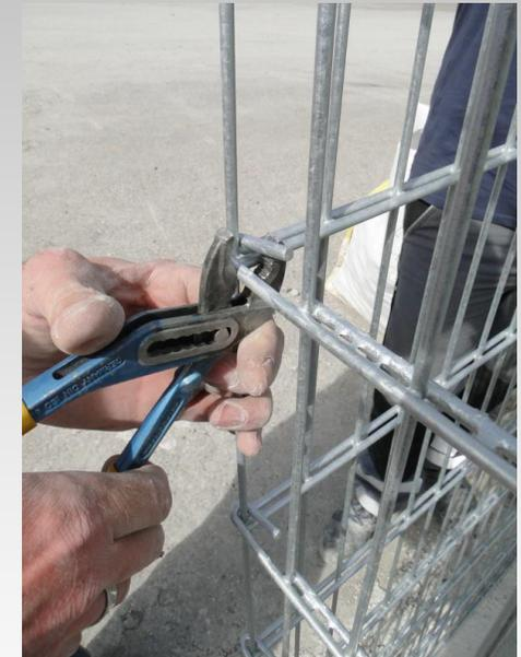
Nach erfolgreichem Zusammenbau der 2 Winkelgitter erfolgt das Einbringen der Distanzhalter. Diese positionieren Sie bitte nach dem dazugehörigen Einbauplan.
