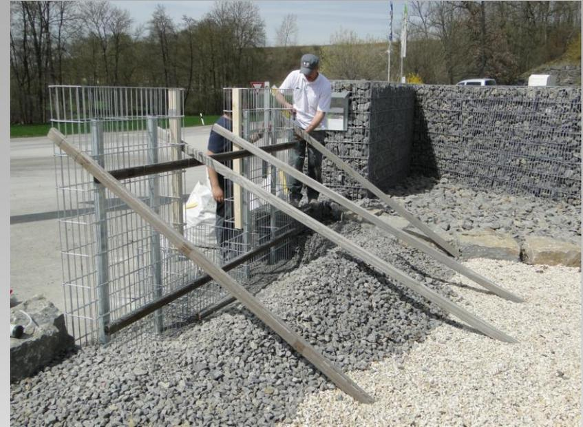
Nach dem Aussteifen wird die Gesamtkonstruktion ausgerichtet und versteift.
