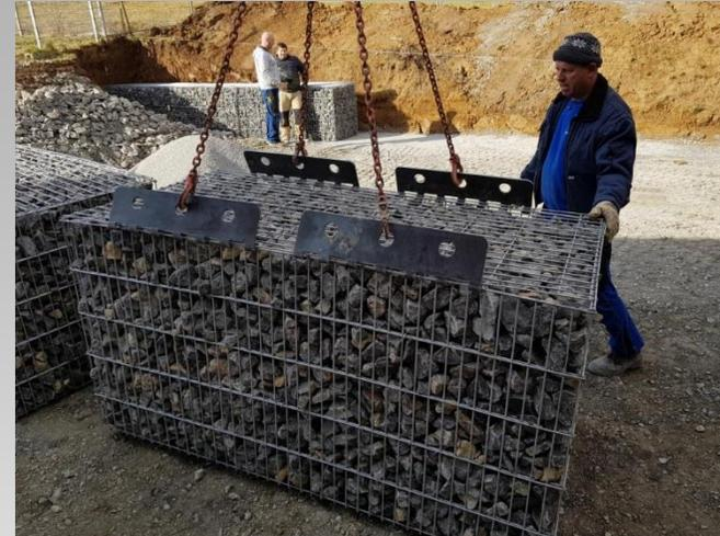
Eine handelsübliche 2er/4er Kette mit entsprechender Nutzlast muss in die Ösen der Hebekrallen eingehängt werden.
